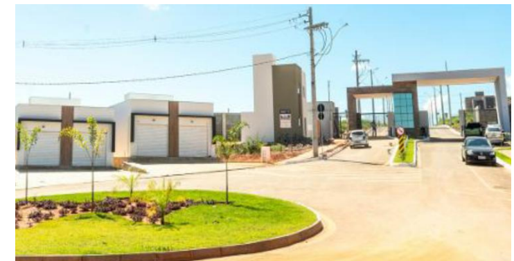
Entrada do empreendimento
